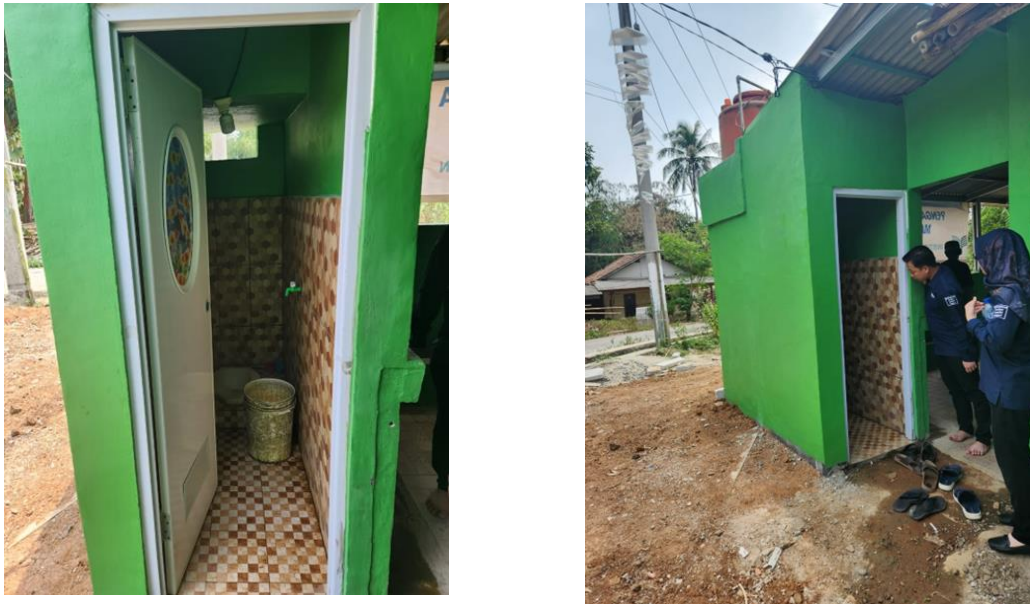
Gambar 9. Hasil renovasi toilet
