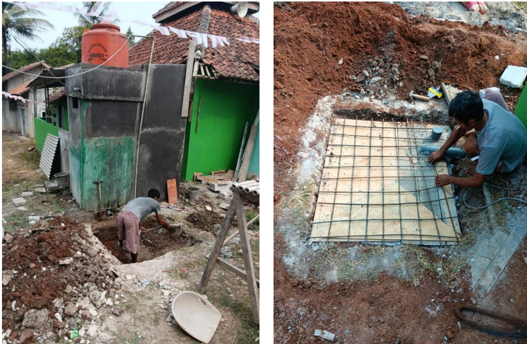
Gambar 7. Pelaksanaan Pembangunan Toilet dan Septic Tank
