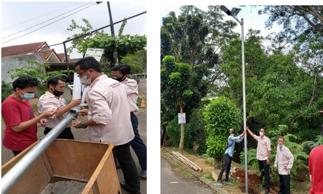
Gambar 7. Perakitan Lampu LED PLTS dan Pemasangan Tiang Lampu
