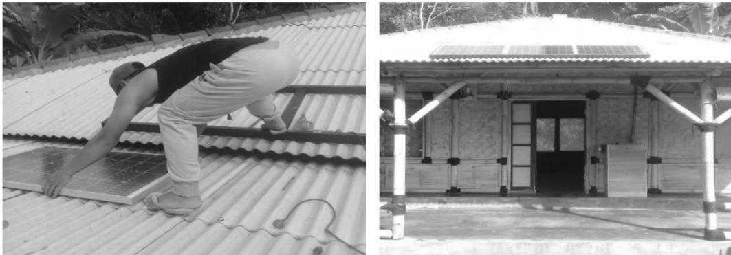
**Gambar 8.** Pemasangan panel surya
