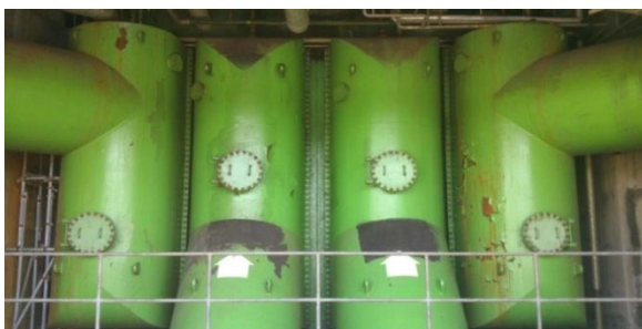
Gambar 1. Kondensor PLTU Rembang
