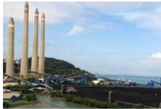
Gambar 2A. Coal yard PLTU Suralaya 4 x 400 MW dan 3 x 600 MW di Jawa Barat di mana tampak conveyor pengangkut batu bara dan cerobong.
