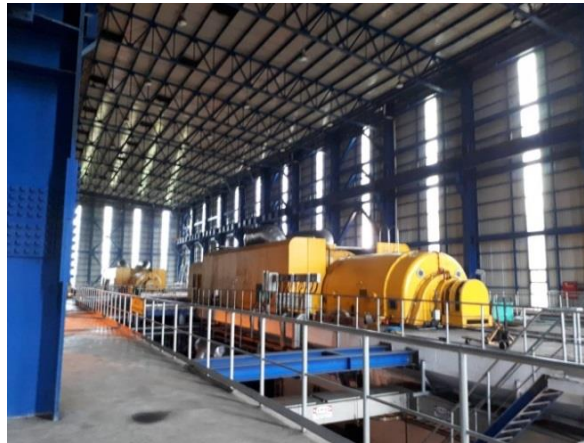
Gambar 7. Turbin uap (Sumber: Dokumentasi Penulis)
