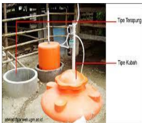
Gambar 2. Tipe Alat Pembangkit Biogas/Digester
