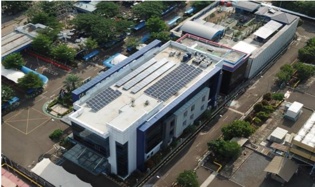
Gambar 2. PLTS On Grid pada Gedung Administrasi
