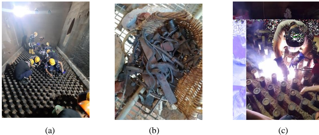
Gambar 4. (a) inspeksi (b) benda asing (c) perbaikan nozel
