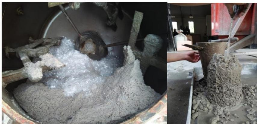
a. Pencampuran Material Penyusun Beton                      b. Pengujian Nilai Slump
