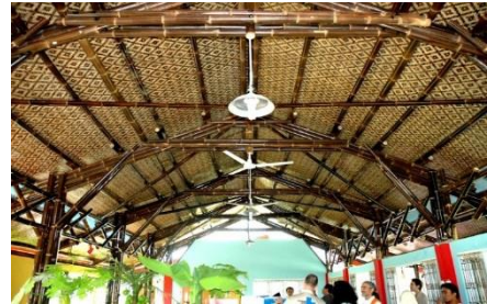
Gambar 4. Kuda-kuda bambu pada bangunan TK ABA Semoya, Berbah, Sleman
