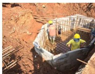
Gambar 7 : Bekisting Batako (Sumber : Dokumentasi Magang)
