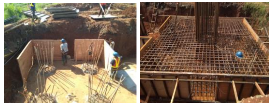
Gambar 2 : Bekisting Sistem (Sumber : Dokumentasi Magang)
