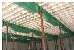
Gambar 4 Bekisting Fiberglass (Sumber : Diolah Penulis 2017)
