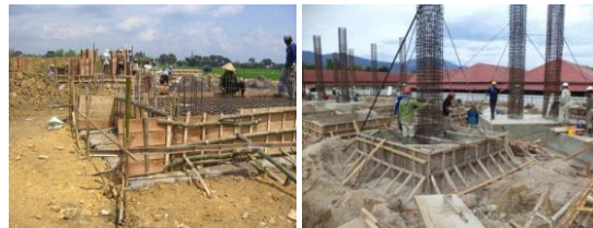
Gambar 1 : Bekisting Konvensional (Sumber : Diolah Penulis 2017)
