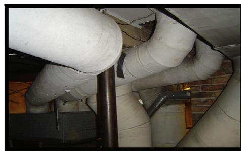
Pemanfaatan bahan asbes sebagai insulasi panas dalam bidang keteknikan (sumber: [asbestoslabs.com.au](http://asbestoslabs.com.au), diunduh: 06 April 2015)
