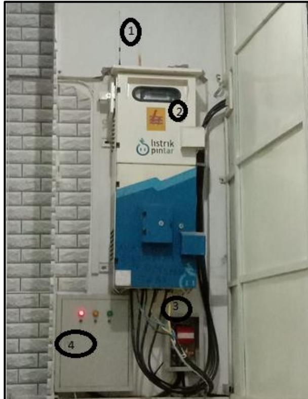
**Gambar 9.** Pemasangan arester di kWh meter
